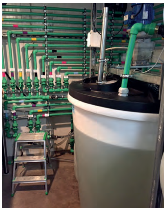
FOT. 2 Testy metod biologicznych oczyszczania ścieków z mokrego odsiarczania spalin
