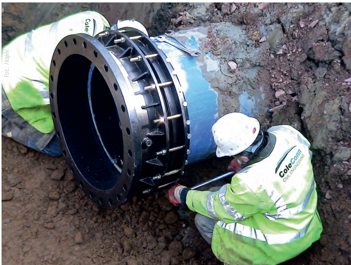
ŁĄCZNIK MGR-F na rurociągu PE
