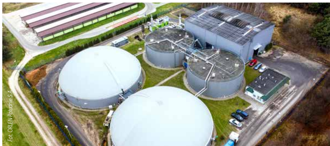
BIOGAZOWNIA Jedna z trzech biogazowni, które Grupa ORLEN posiada w swojej strukturze
