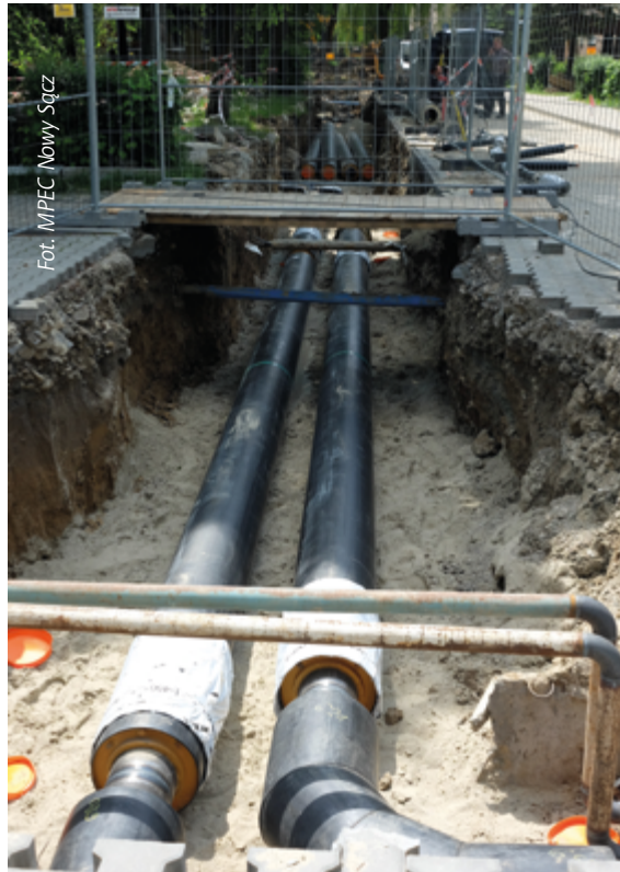
FOT. 3 Fragment modernizowanej w 2020 r. sieci ciepłowniczej – w ramach projektu dofinansowanego z UE
