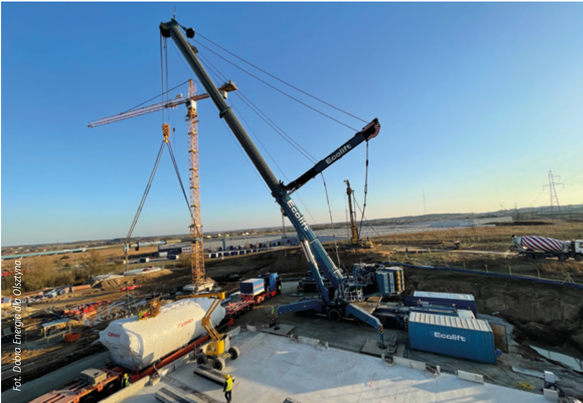
FOT. 3 Posadowienie kotłów
