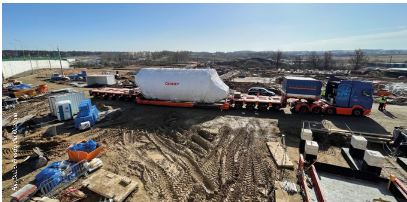
FOT. 2 Transport 90-tonowych kotłów
