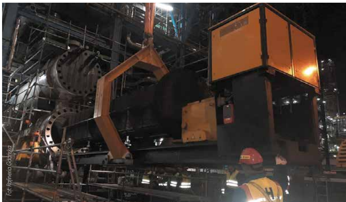
FOT. 1 Demontaż wkładu wysokociśnieniowego wymennika instalacji hydrokrakingu
